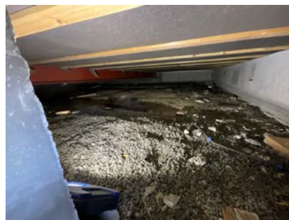
Krypkjeller sett fra inspeksjonsluke
