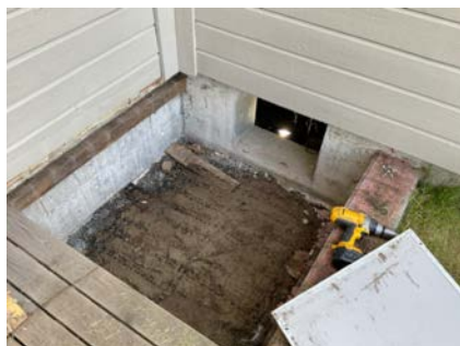
Inspeksjonsluke under tralleverk
