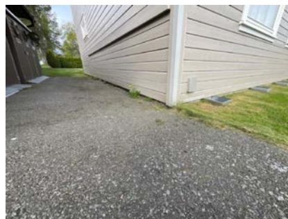
Bordkledning tett på terreng
