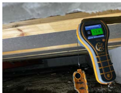
Fuktmåling i krypkjeller
