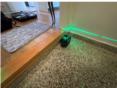
Overflate på baderomsgulv
