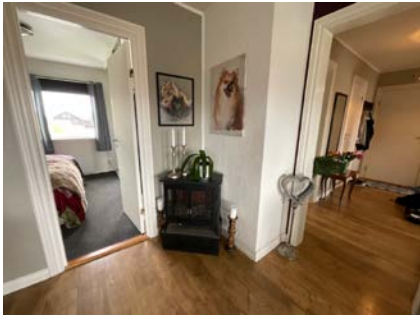
Pipe synlig i stuen
