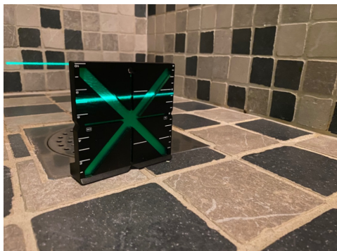
Måling av fall til sluket
