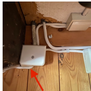
Ufagmessig montering av koblingsboks.
