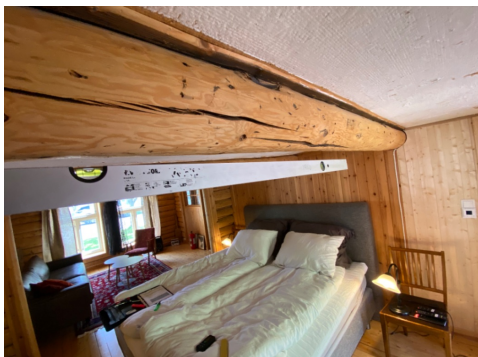
Skjevheter takbjelker.
