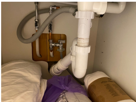
Kontroll av røropplegget.
