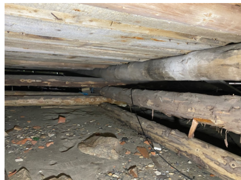
Bygningen er fundamentert på tømmer mot mark/sanholdige masser samt tømmer mot natursteinsmur.
