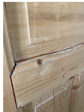
Trevirke i dører har sprekker fra tørking.
