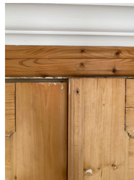
Trevirke i dører har sprekker fra tørking.
