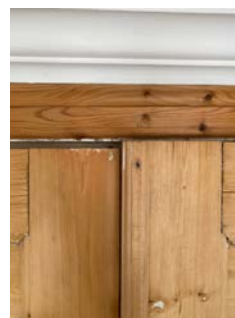
Trevirke i dører har sprekker fra tørking.
