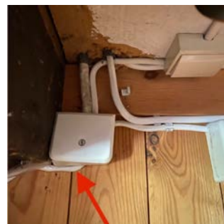
Ufagmessig montering av koblingsboks.
