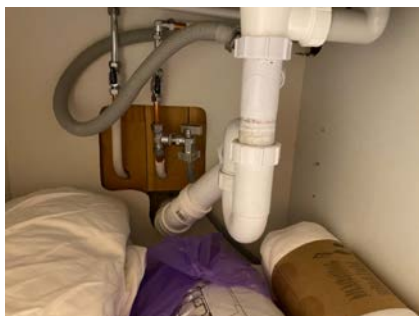
Kontroll av røropplegget.
