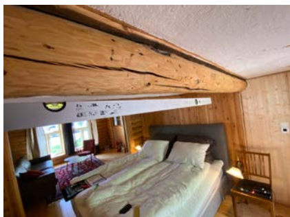
Skjevheter takbjelker.
