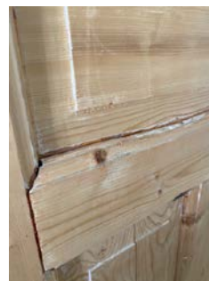
Trevirke i dører har sprekker fra tørking.
