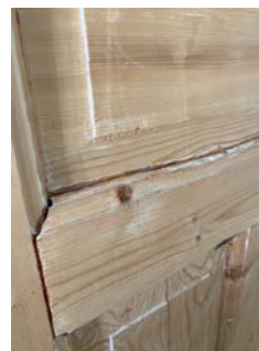
Trevirke i dører har sprekker fra tørking.
