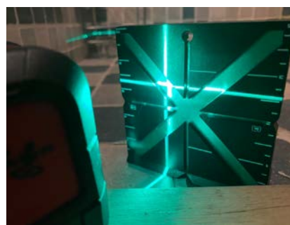
Måling av fall fra døråpning.
