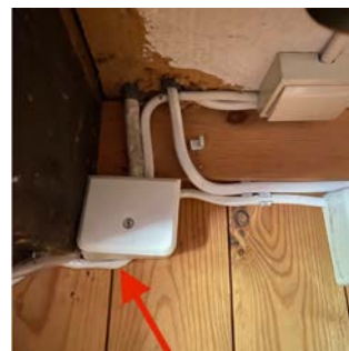
Ufagmessig montering av koblingsboks.
