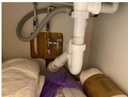
Kontroll av røropplegget.
