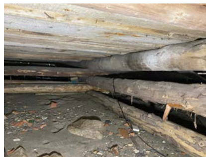
Bygningen er fundamentert på tømmer mot mark/sanholdige masser samt tømmer mot natursteinsmur.
