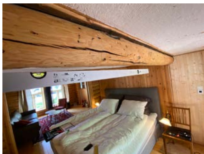
Skjevheter takbjelker.
