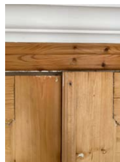
Trevirke i dører har sprekker fra tørking.
