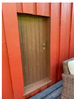
Dør for 2. etg har ikke tilgang fra innsiden. Det mangler beslag over og under døren.
