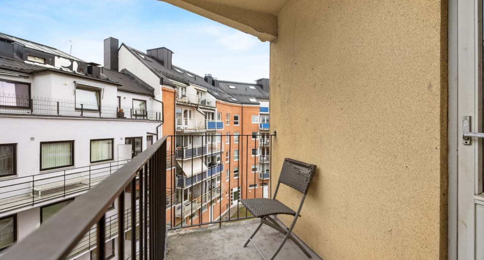
I hver etasje er det felles balkong for beboerne. Denne leiligheten ligger nærmest balkongen i femte etasje
