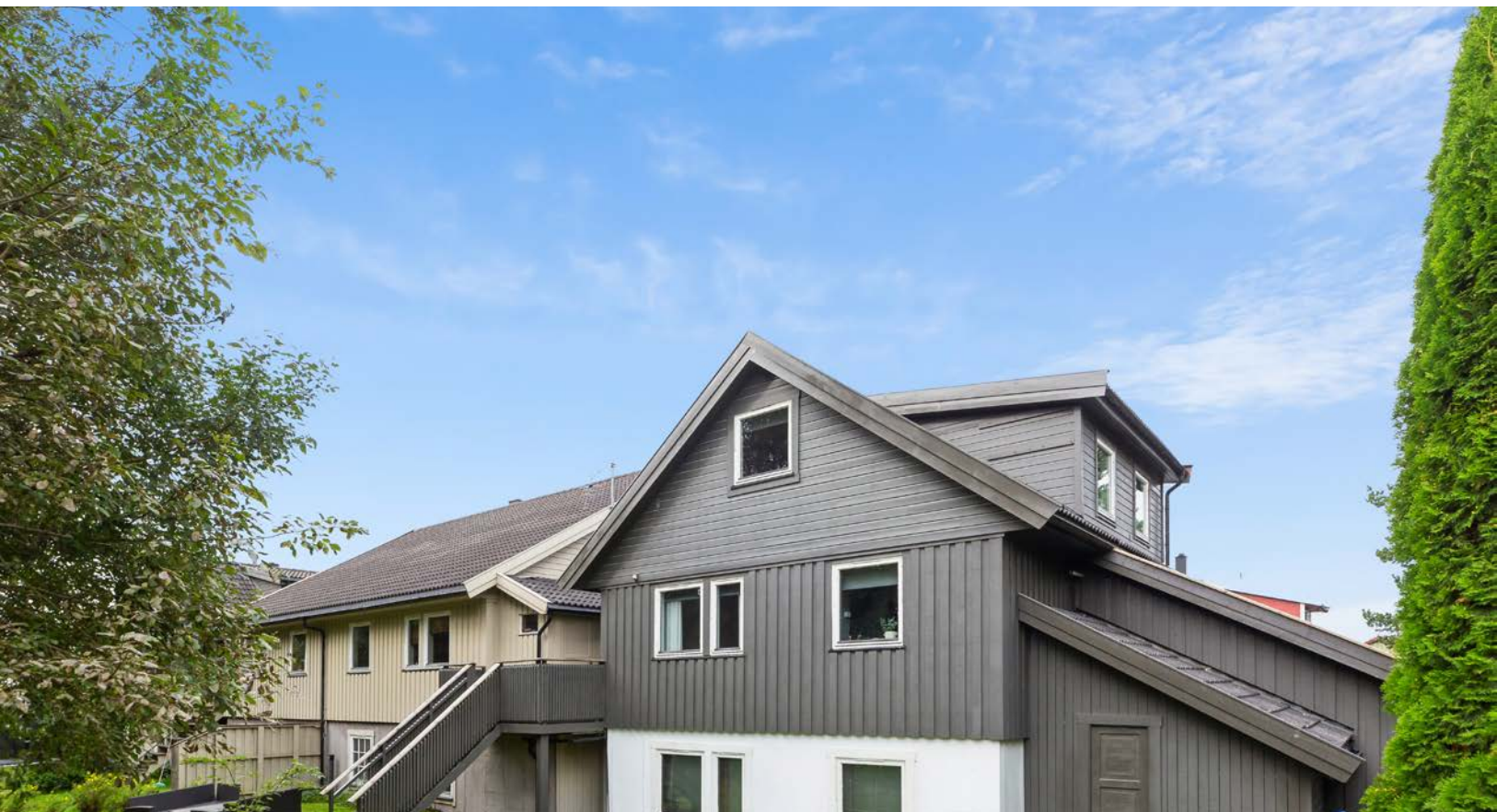
Tomannsboligen har en pen fasade som fremstår som godt vedlikeholdt.
