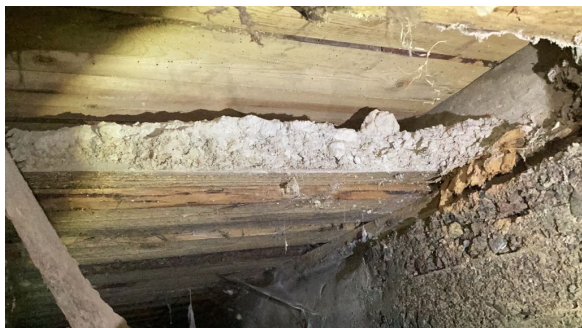
Isolert med leire på kontrollpunkt mellom kjeller og 1. etasje.
