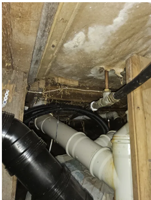
Bilde viser avløpsrør i kjeller.
