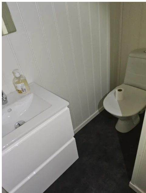
Bilde viser toalettrom.
