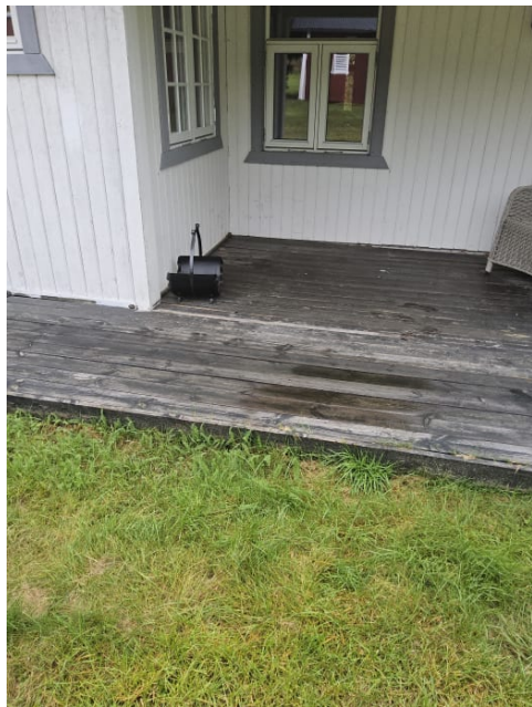
Bilde viser terrasse som skjuler grunnmur.
