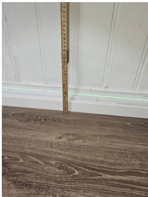
Bilde viser måling av etasjeskiller.
