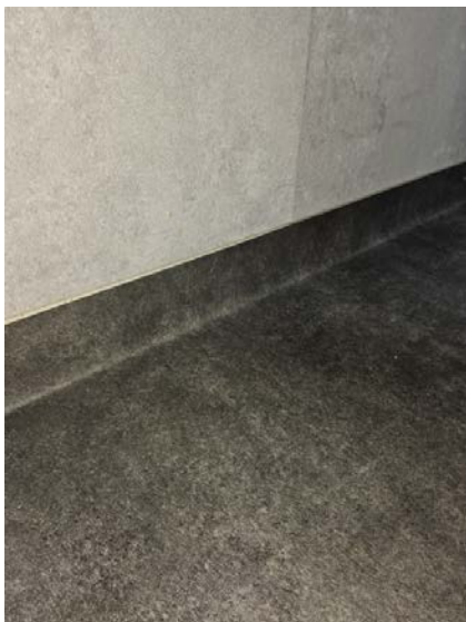
Bilde viser buling i baderomsplate.
