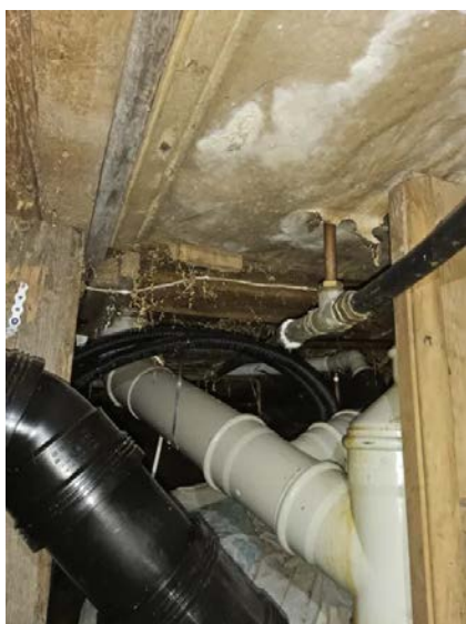
Bilde viser avløpsrør i kjeller.
