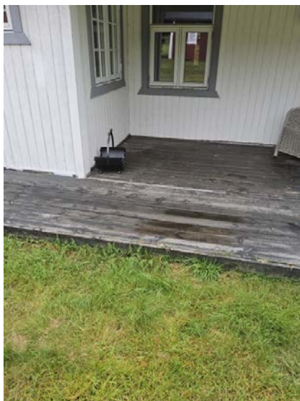
Bilde viser terrasse som skjuler grunnmur.
