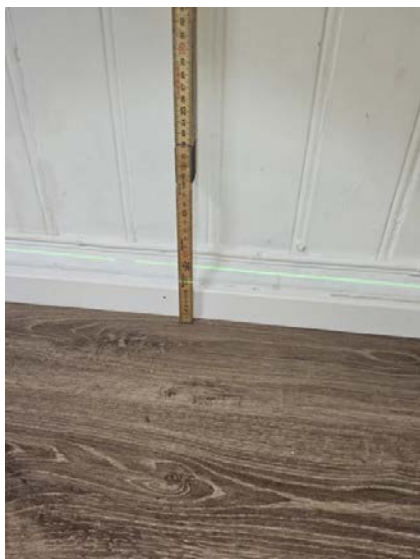
Bilde viser måling av etasjeskiller.
