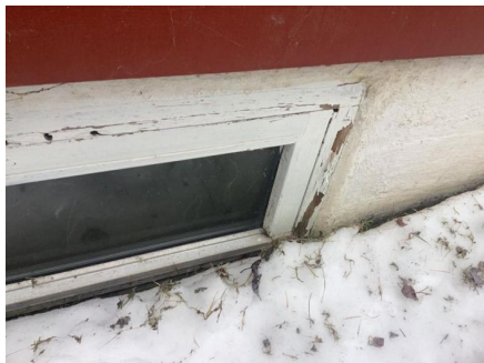
Kjellervinduer ligger stedvis delvis ned i terreng.
