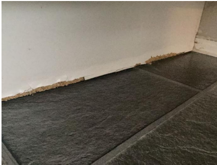
Eksempel på slitasje på sokler.
