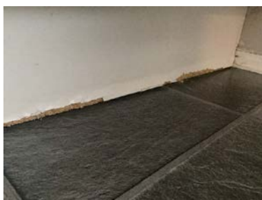
Eksempel på slitasje på sokler.
