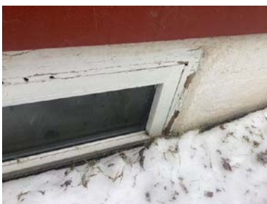
Kjellervinduer ligger stedvis delvis ned i terreng.
