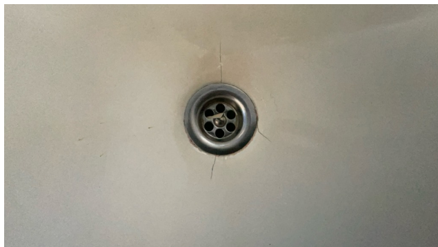
Sprekker mot bunnventil
