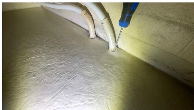
Utette rørgjennomføringer
