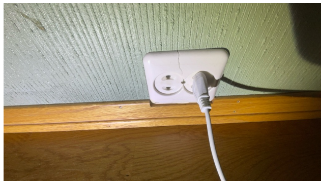
Sprekk i deksel til kontakt ved trapp
