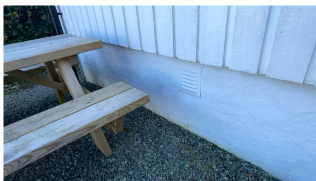
Ventilert mur på yttre del av tilbygg
