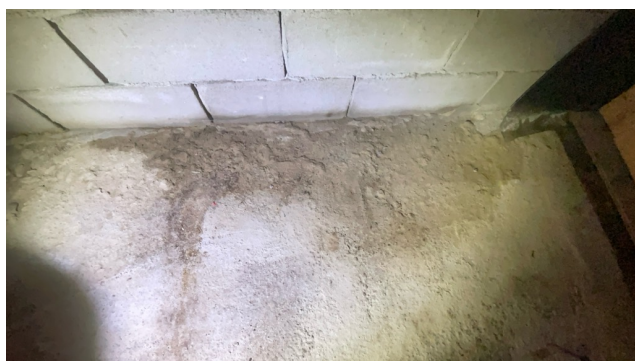
Skjolde nedkant vegg grovkjeller
