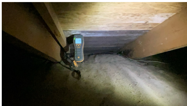
Fuktmåling loft ved flass kjøkkenvegg uten spesielle avvik (litt skjolde på takstolende)
