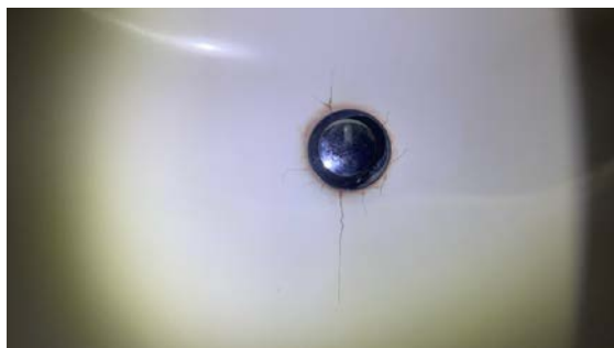
Sprekker mot bunnventil
