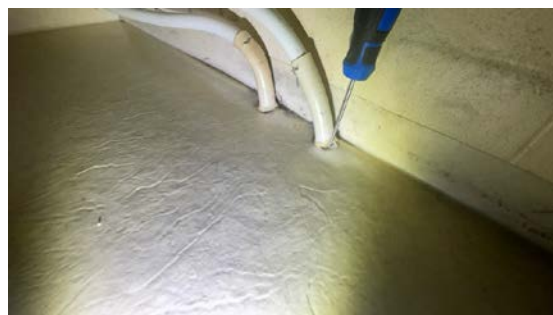
Utette rørgjennomføringer
