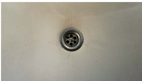
Sprekker mot bunnventil
