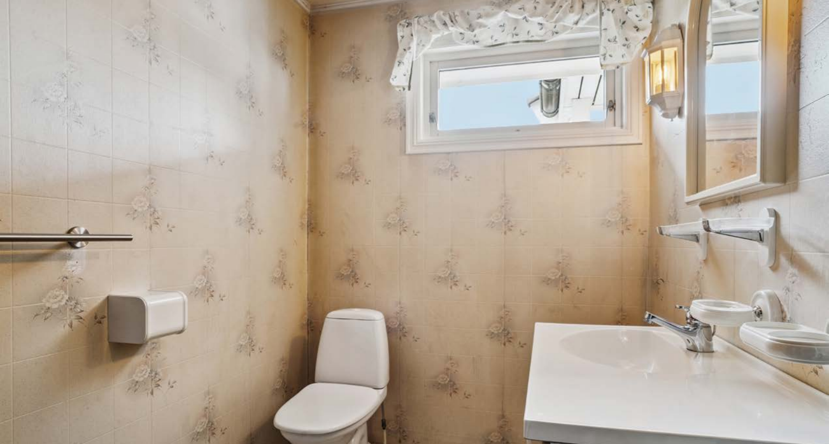
Bad med vinyltapet på vegger, vinylbelegg på gulv, gulvstående toalett og heldekkende servant i innredning.
