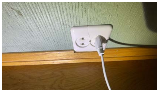
Sprekk i deksel til kontakt ved trapp
