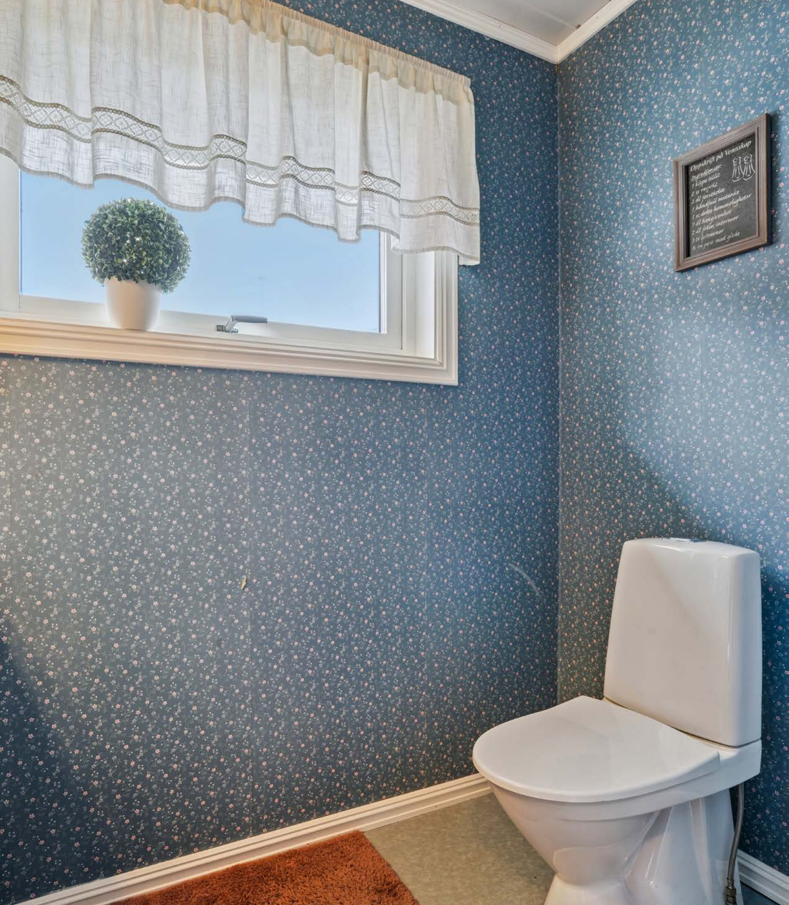
Toalettrom med tapet på vegger og vinylbelegg på gulv.
