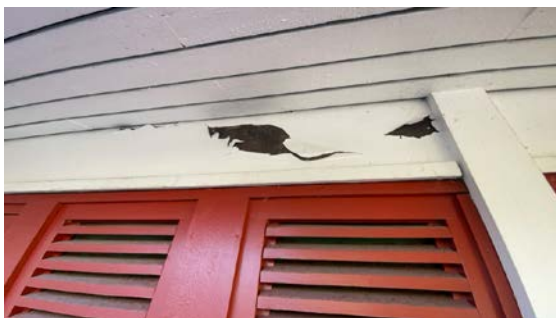
Flasset/svertet fineer ved kjøkkenvindu
