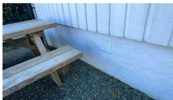
Ventilert mur på yttre del av tilbygg
