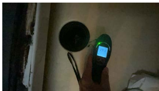
Fuktsøk ved sluk ok
