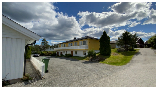
Besiktigelse av taktekke.
