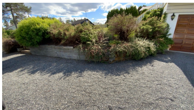
Besiktigelse av støttemur.
