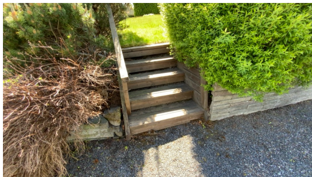
Besiktigelse av trapp.
