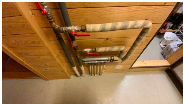
Besiktigelse av røropplegg.
