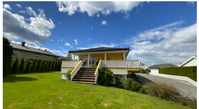
Besiktigelse av taktekke.
