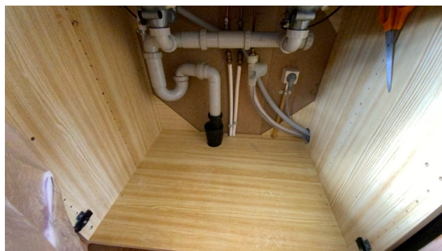
Besiktigelse av røropplegg.
