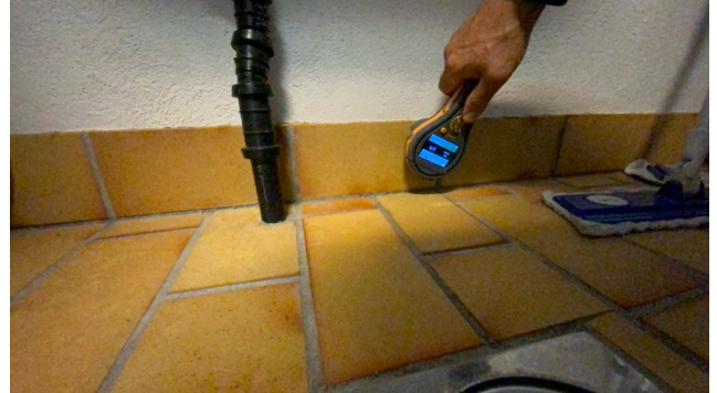
Ingen høye fuktverdier ble indikert på befaringsdagen.
