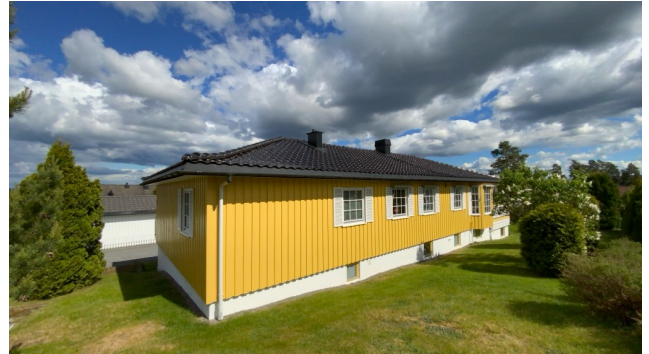
Besiktigelse av taktekke.
