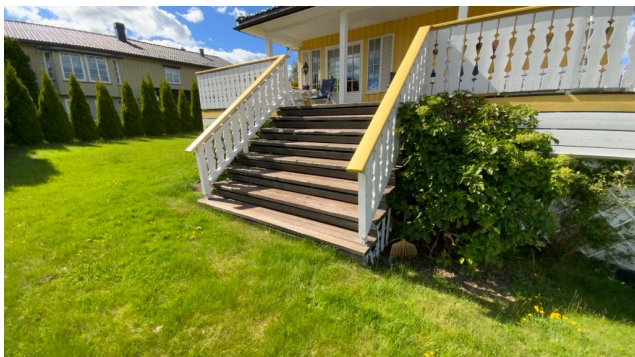
Besiktigelse av trapp.
