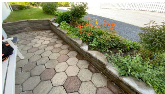
Besiktigelse av støttemur.
