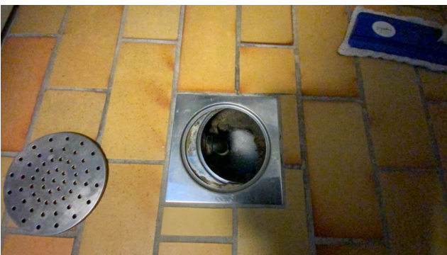
Kontroll av sluk.
