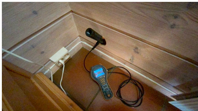
Utført hulltaking på rom under tereng.
