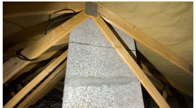
Kontroll rundt pipeløp.
