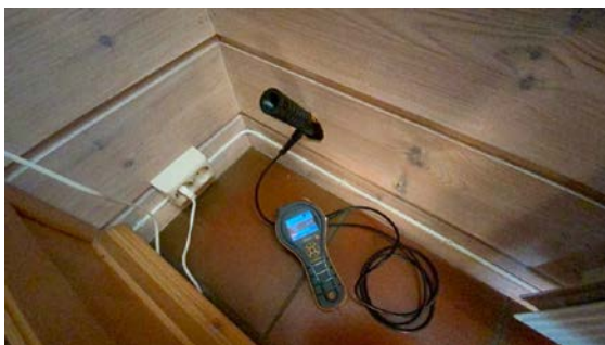
Utført hulltaking på rom under terreng.
