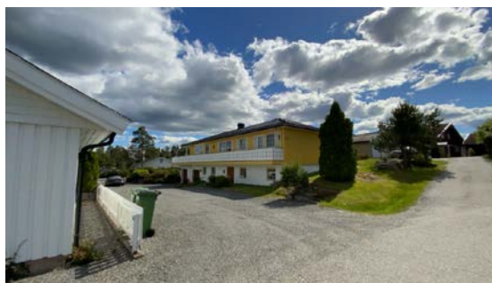
Besiktigelse av taktekke.
