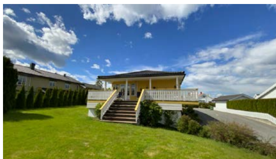
Besiktigelse av taktekke.
