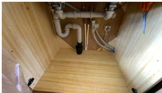
Besiktigelse av rørøpplagg.
