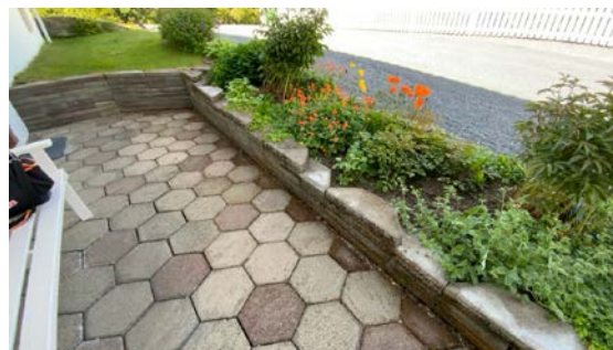
Besiktigelse av støttemur.
