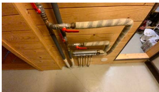
Besiktigelse av rørøpplagg.
