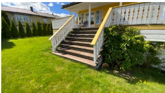
Besiktigelse av trapp.
