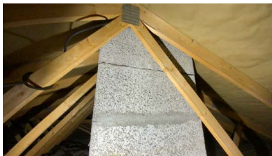
Kontroll rundt pipeløp.
