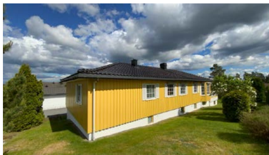
Besiktigelse av taktekke.
