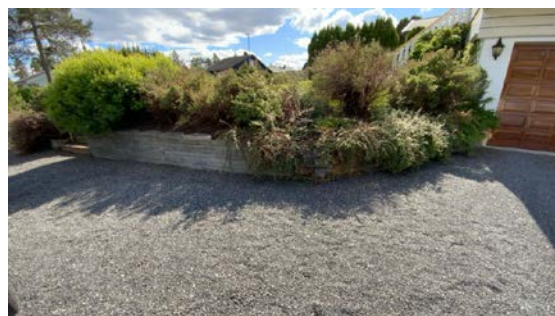
Besiktigelse av støttemur.
