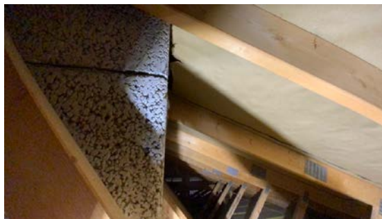
Utettheter rundt pipeløp.
