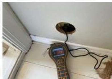
Hullboring (73 mm i diameter) for visuell inspeksjon og fuktmåling.
