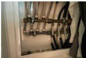
Fordelerskap til rør-i-rør
