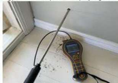
Måling av luftfuktighet (RF), målt til 82,2 %.
