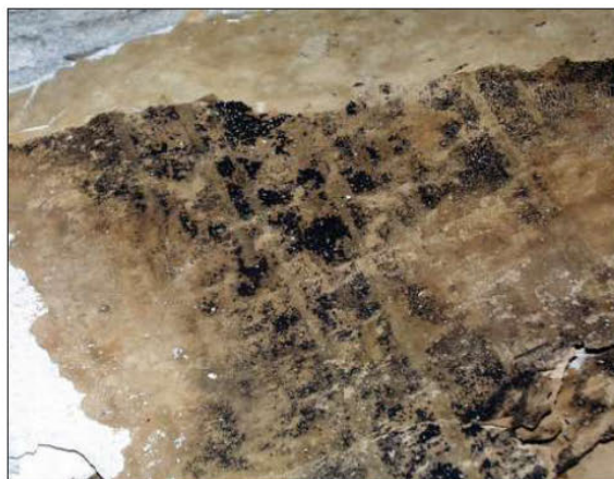
Vekst av Chaetomium på baksiden av papirtapet. Tapetet hadde vært utsatt for høy fuktighet over lengre tid. Det kan være vanskelig å oppdage forekomst av Chaetomium på tapeter fordi den ofte trives best på baksiden inn mot veggen eller veggkonstruksjonen.
