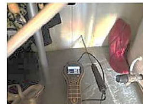
Måling med fuktprobe. Det ble også boret hull på 75 mm i diameter for visuell inspeksjon.
