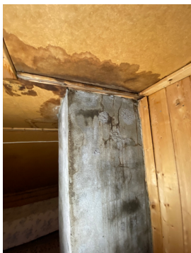
Tak i loftsetasjen rundt pipeløp.
