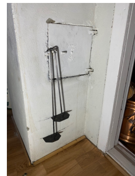
Sprekk i pipe bak vedovn på kjøkken.
