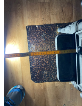
Brennbar plate under vedovner er for liten.
