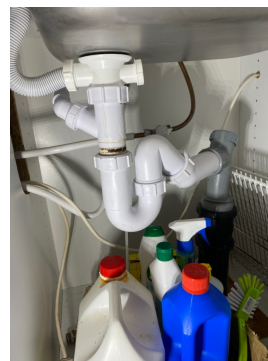
Kontroll av røropplegget på kjøkkenet.
