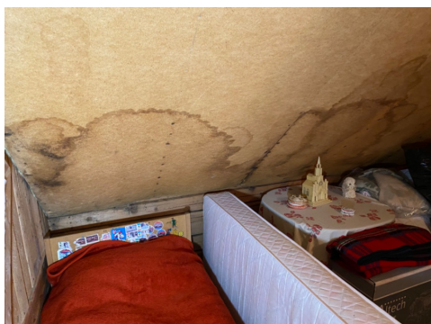
Tak i loftsetasjen
