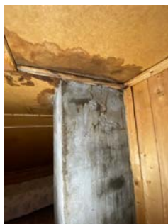
Tak i loftsetasjen rundt pipeløp.
