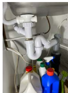
Kontroll av røropplegget på kjøkkenet.
