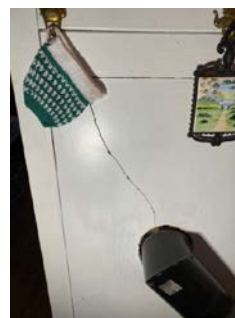
Sprekk i pipe bak vedovn på kjøkken.
