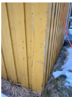
Bordkledning går stedvis nesten helt ned i terreng.
