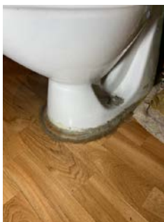
Ikke fagmessig tetting rundt toalett.
