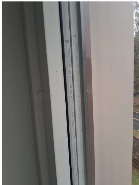
Leiligheten har vinduer med tre-lags glass fra 2011.
