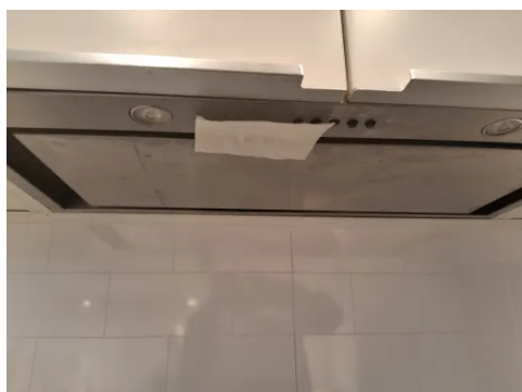
Avtrekkseffekt er testet med papir.
