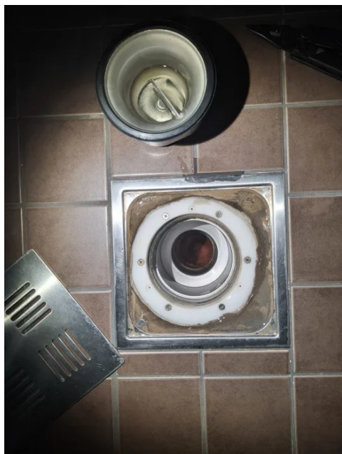
Det ble ikke avdekket tegn til avvik i overgang membran/sluk.
