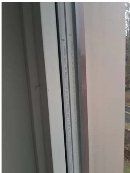
Leiligheten har vinduer med tre-lags glass fra 2011.
