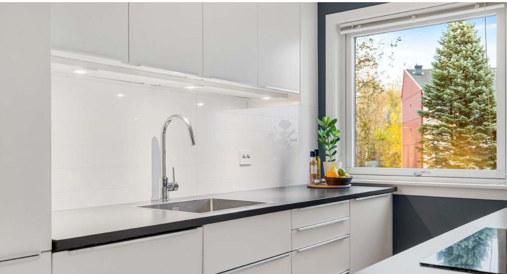
Benkeplate i laminat med nedfelt oppvaskkum i rustfritt stål med ett-greps blandebatteri. I benkeryggen er laminatplate for enkel rengjøring
