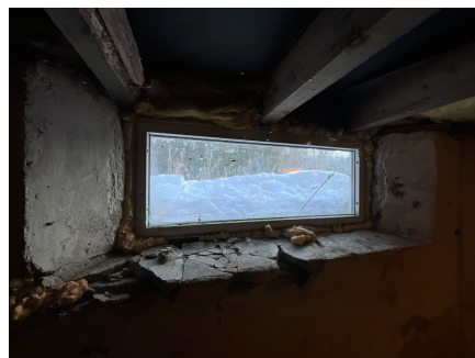
Oppspreking rundt vindu
