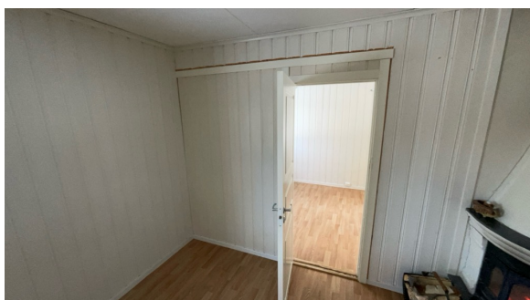
Bilde av delingsvegg mellom stue og soverom
