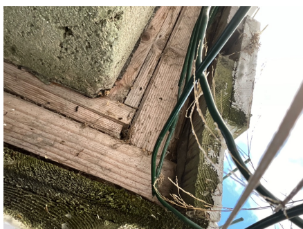
Bilde tatt av løsning bak ytterkledning
