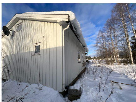
Oversiktsbilde av takrenne nedløp
