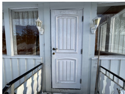
Dør inn til inngangsparti
