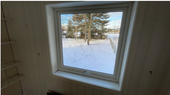
Vindu på soverom
