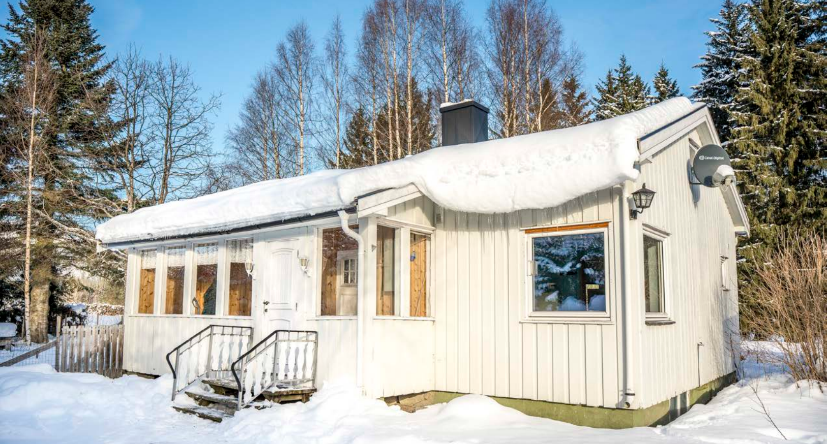
Enkel bolig med noe etterslep på vedlikehold og oppgraderinger av enkelte bygningsdeler. Modernisering av isolasjon på loft i 2016: Fjernet kutterspon og tilført ny mineralull 150cm.
