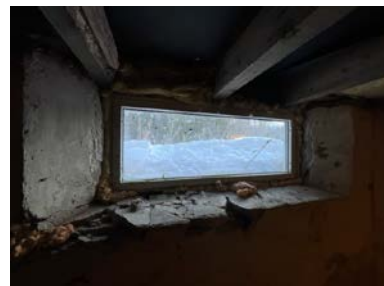
Oppspreking rundt vindu
