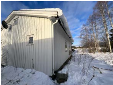
Oversiktsbilde av takrenne nedløp
