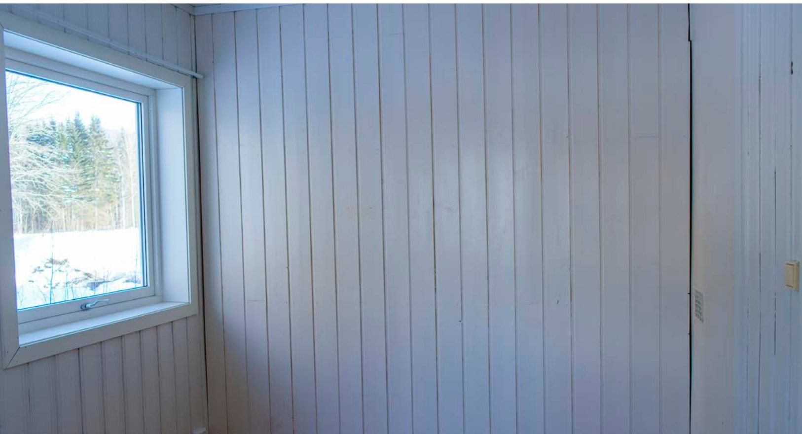
Soverom 2. Dette var tidligere en del av stuen, det er satt opp lettvegg og dør.
