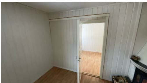
Bilde av delingsvegg mellom stue og soverom
