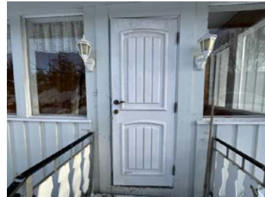
Dør inn til inngangsparti
