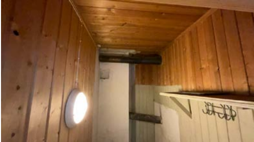
Røykrør. Gjeldene rør er det nederst som går fra ildsted på kjøkken til Peis på stue pipløpet
