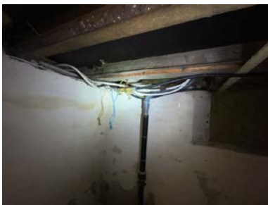
Oversiktsbilde røranlegg under bad
