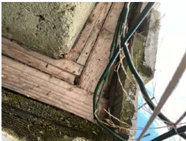
Bilde tatt av løsning bak ytterkledning
