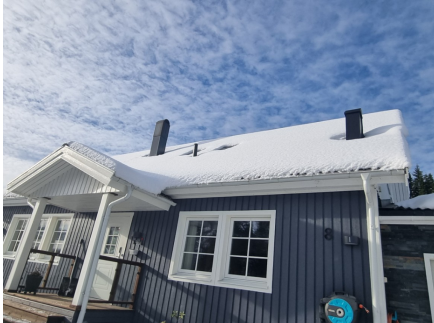
Oversikt mot pipe og avløpsluftung
