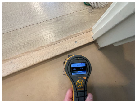
Fuktsøk på gulv ved dør til kjøkken uten forhøyde fuktavvik
