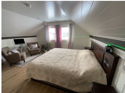
Loft Plassering av laser ved kontroll av soverom 1. Det er målt 4 mm høydeforskjell gjennom rommet. TG 1
