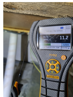
Fuktkontroll i krypkjeller viser 11,7%. Ingen forhøyde fuktavvik
