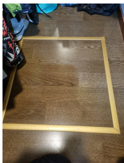
Luke i gulv på bod/garderobemed tilgang til krypkjeller
