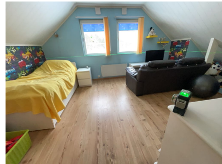
Loft Plassering av laser ved kontroll av soverom 2. Det er målt 6 mm høydeforskjell gjennom rommet. TG 1
