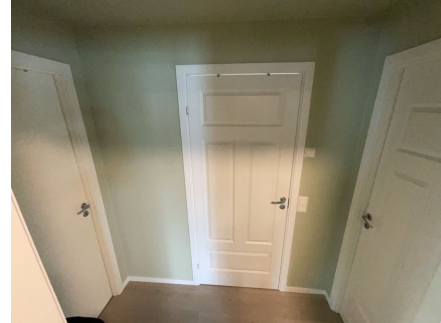
Dører til garderobe, bad og soverom i 1. etasje
