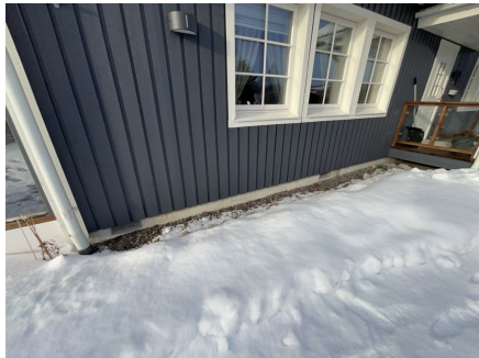
Synlige lufteventiler i dragere/grunnmur
