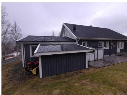
Bilde tatt ved ny befaring 19.03.2025
