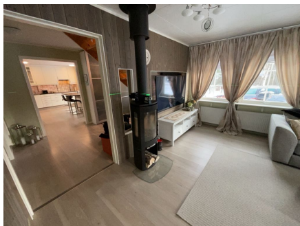
1. etasje Plassering av laser på vedovn ved kontroll av stue. Det er målt 5mm høydeforskjell gjennom rommet. TG 1
