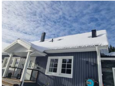
Oversikt mot pipe og avløpslufting
