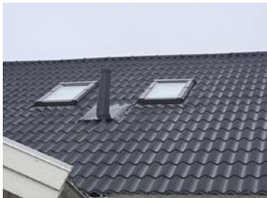
Bilde tatt ved befaring 19.03.2025
