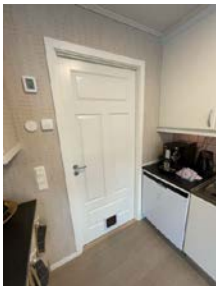
Dør til vaskerom sett fra kjøkken hvor det er montert katteluke
