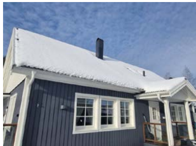
Takstige opp til pipe
