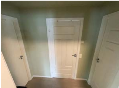
Dørrer til garderobe, bad og soverom i 1. etasje
