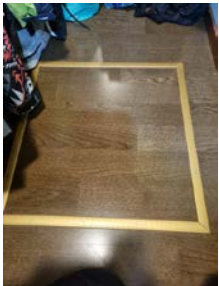
Luke i gulv på bod/garderoberom med tilgang til kryp kjeller
