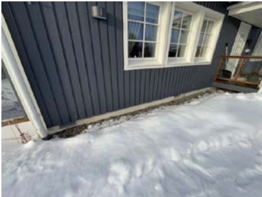
Synlige lufterventiler i dragere/grunnmur
