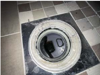
Smøremembran/mansjett er ført ned under klemring på plastsluken
