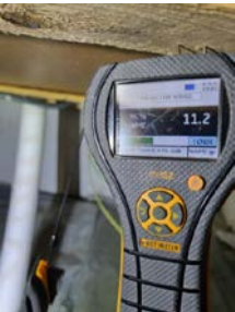
Fuktkontroll i kryp kjeller viser 11,7%. Ingen forhøyde fuktavvik
