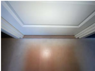
Liten tilluftsspalte under dør
