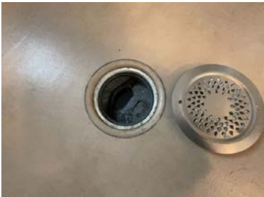
Vinylbelegg er ført ned under klemring i sluk.
