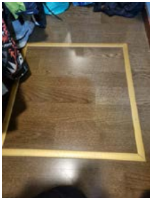
Luke i gulv på bod/garderobemed tilgang til kryp kjeller
