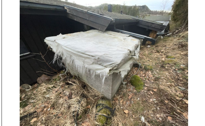
Eldre systerne, som på befaringsdagen brukes til lagring.
