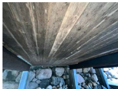
Stubbegulv mot sjøvann.
