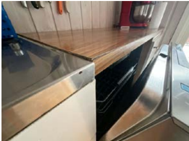
Svelling i benkeplate.
