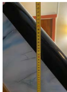
Høyde rekkverk (trapp mellom 1 og 2 Etg.)
