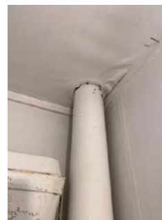
Tegn på fukt i taket rundt rørgjennomføring.
