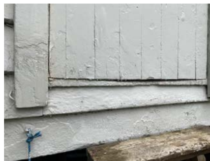
Råteskader boddør.
