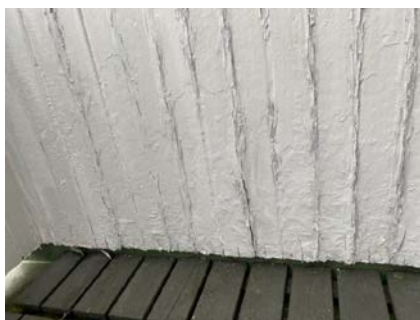
Råteskader i trevirke på rekkverk.
