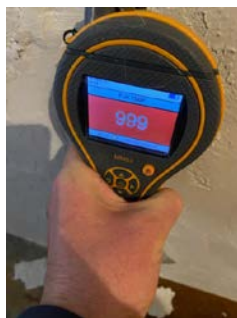
Fuktmåling mot yttervegg, gangen.
