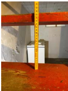
Åpninger mellom trinn ca. 19 cm.
