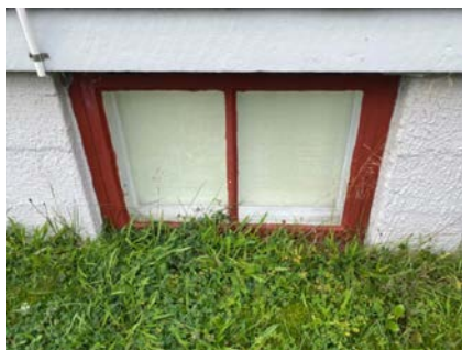
Vindu mot vest i underetasjen.
