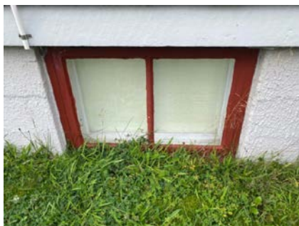
Vindu mot vest i underetasjen.
