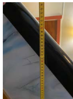
Høyde rekkverk (trapp mellom 1 og 2 Etg.)
