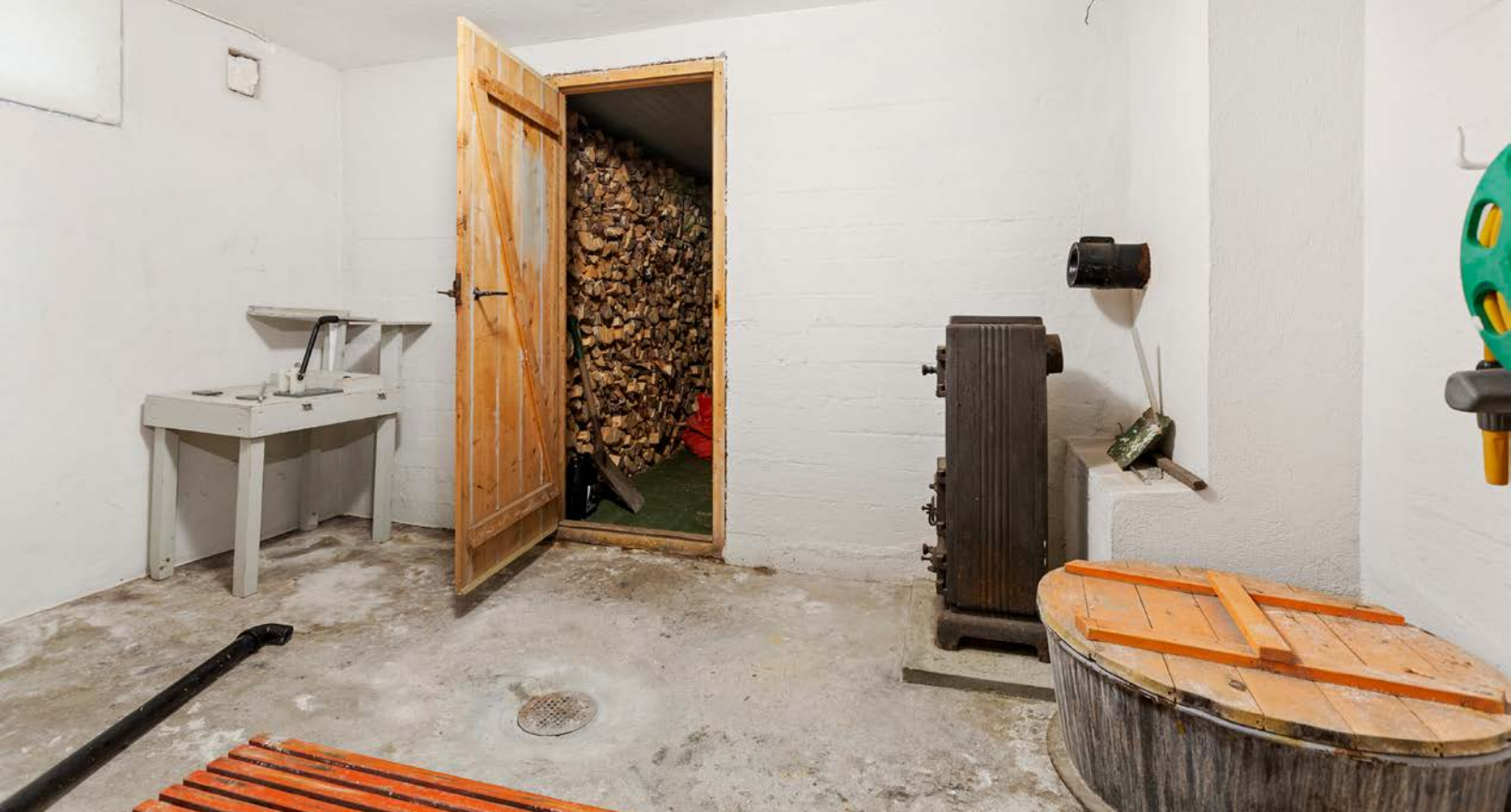
Vaskerom i kjeller er uinnredet.
