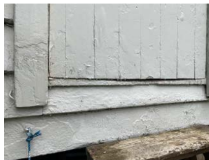
Råteskader boddør.
