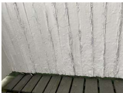
Råteskader i trevirke på rekkverk.
