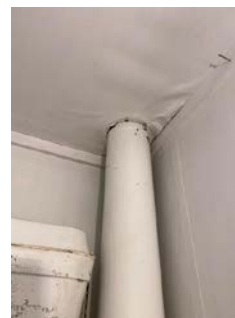
Tegn på fukt i taket rundt rørgjennomføring.
