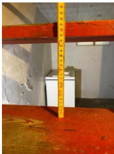
Åpninger mellom trinn ca. 19 cm.
