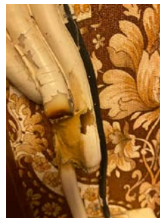
Tegn på varmgang på ledningsnettet, badet i hovedetasjen.
