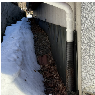
Tilbakefylt betongvegg mot øst
