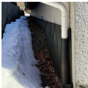
Tilbakefylt betongvegg mot øst
