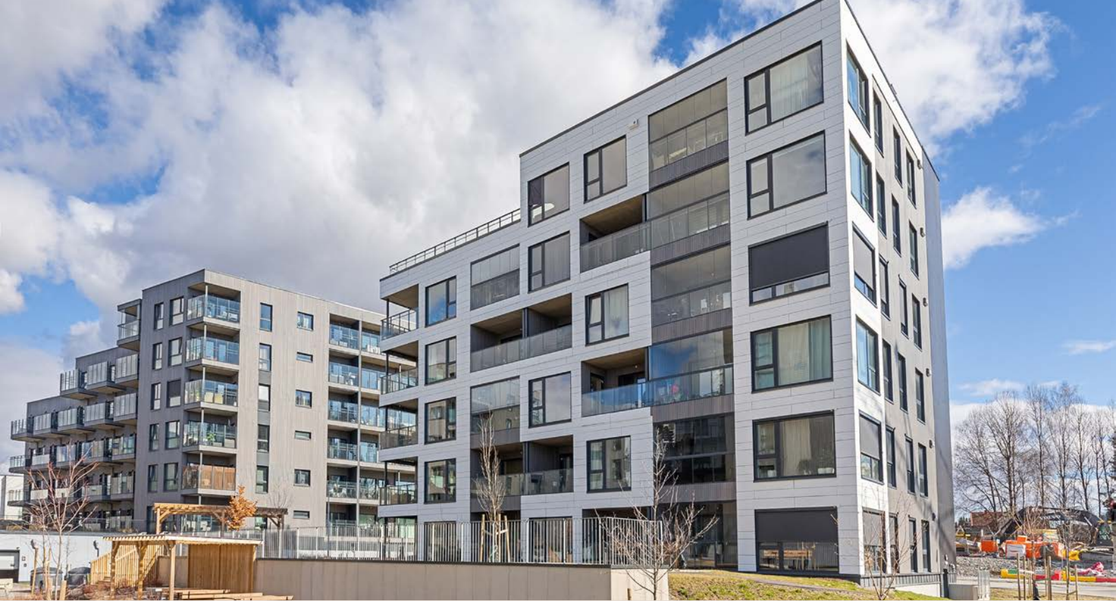
Moderne bygg oppført i 2022
