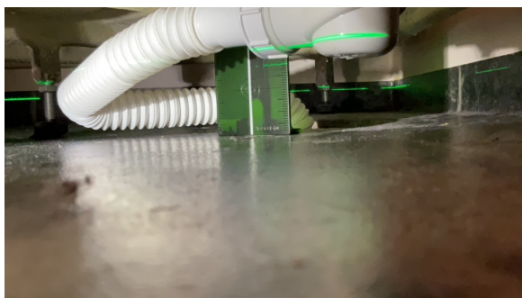
Målt fall til sluk: 10mm
