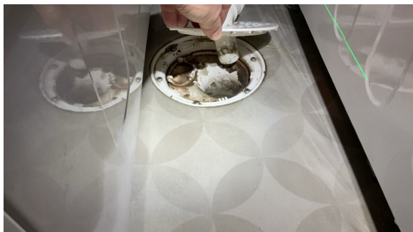
Kontroll av sluk.
