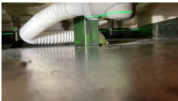
Målt fall til sluk: 10mm
