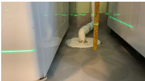
Målt fall til sluk: 50mm
