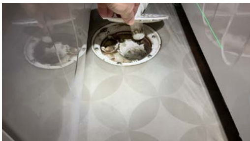
Kontroll av sluk.
