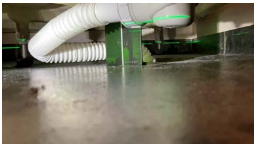
Målt fall til sluk: 10mm
