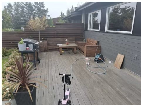
Oversiktsbilde terrasse ved inngangsparti.
