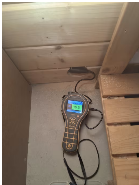
Det utført fuktmåling i utlektet veggkonstruksjon.
