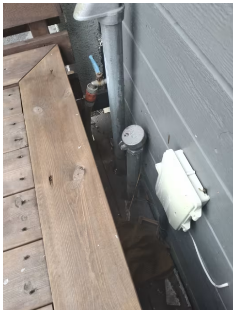
Påfyllingsrør til nedgravd oljetank.
