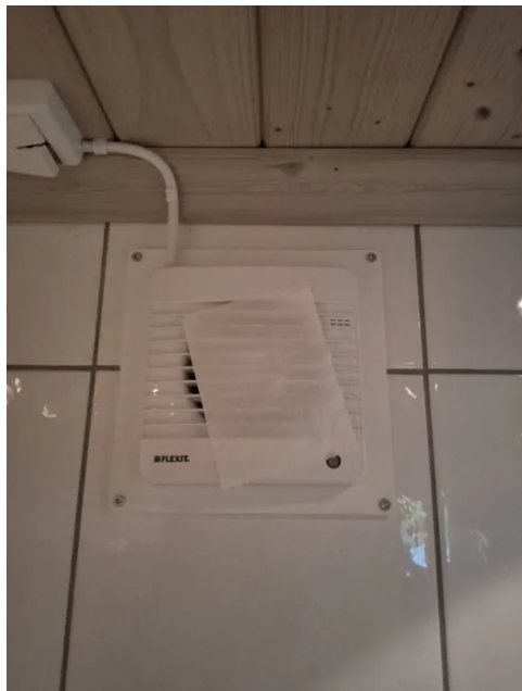
Avtrekkseffekten er testet med papir.
