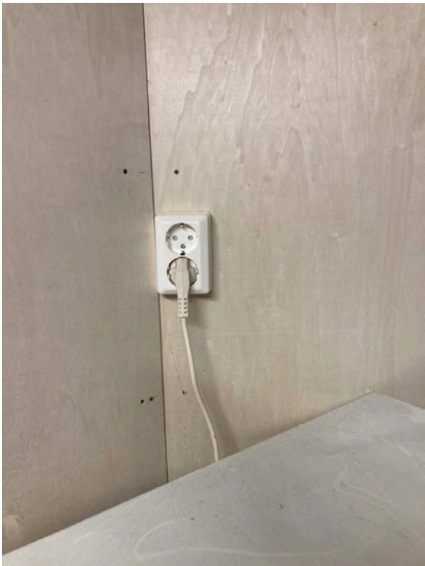
Ny stikk montert. Skjøteledning fjernet.
