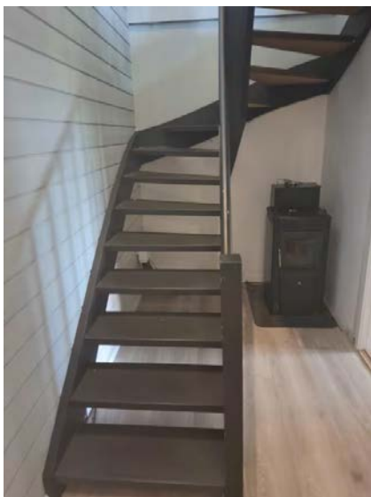
Åpen tretrapp mellom etasjene.
