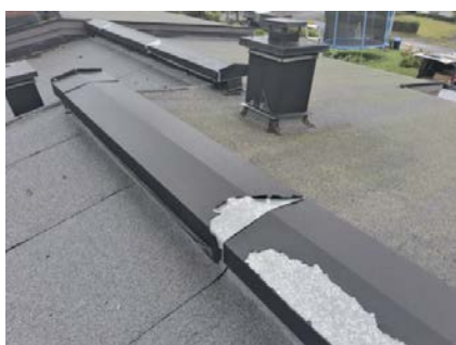
Plastbelegg på beslag flasser av.
