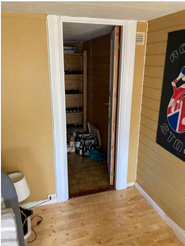
Ny ledning lagt.
