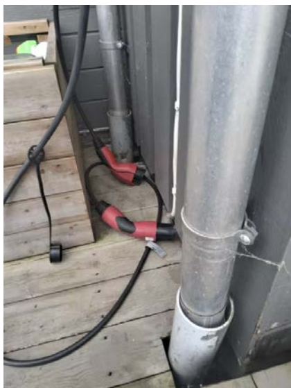
Taknedløp er ført ned i lukkede rør.
