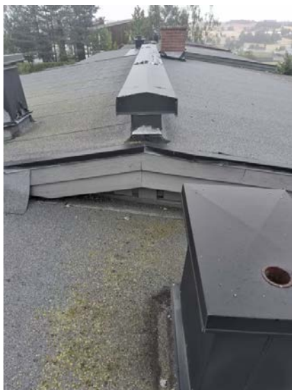
Boligen er oppført med saltak.
