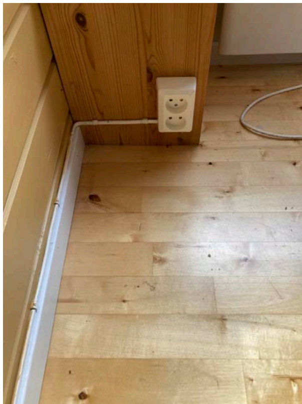
Ny ujordet stikk montert. Ok
