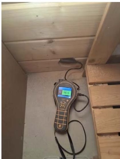
Det utført fuktmåling i utlektet veggkonstruksjon.
