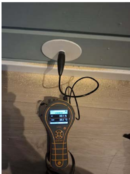
Bilde fra fuktmåling i veggkonstruksjon tilstøtende våtsone.
