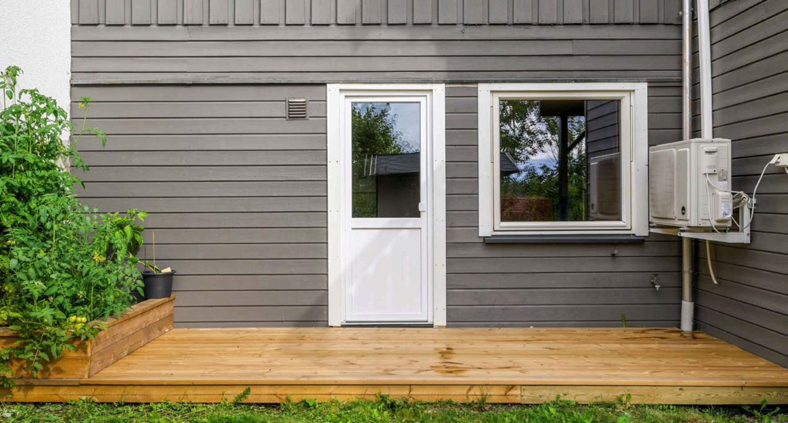
Utenfor stuen er det en terrasse på ca. 6m 2 som ble bygget i 2025.
