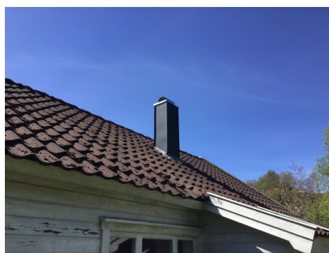
Skader i enden av takrenne, råte i vindskie
