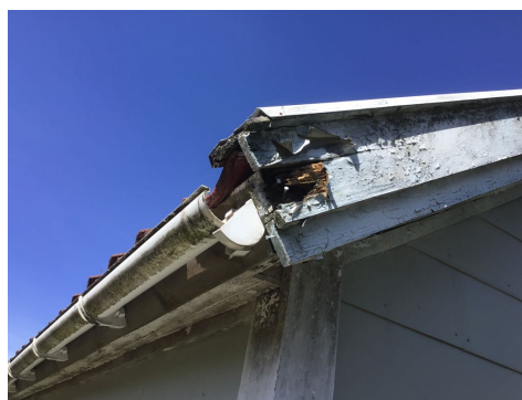
Skader i enden av takrenne, råte i vindskie
