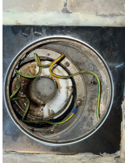
Plastsluk med klemring og synlig membran
