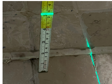
Fallforhold ca. 125 mm overkant gulv ved dusjsone
