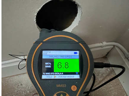
Hulltaking i tilstøtende soverom (bak dusjsone)
