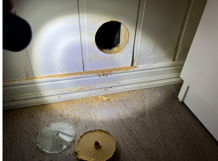
Hulltaking i kjellerbod
