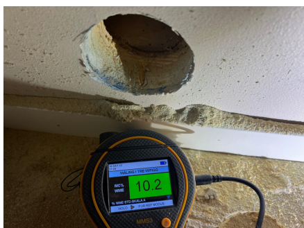
Hulltaking i tilstøtende soverom - fuktsøk med pigger i treverk
