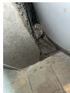
Ufagmessig utførelse overflate og membran
