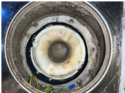
Plastsluk med klemring og synlig membran
