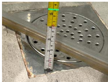
Fallforhold ca. 130 mm topp slukrist i dusjsone
