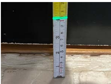
Fallforhold ca. 100 mm overkant gulv ved terskel
