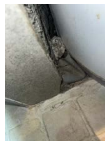
Ufagmessig utførelse overflate og membran
