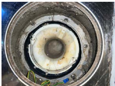
Plastsluk med klemring og synlig membran
