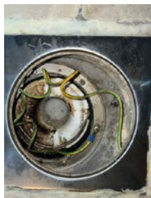
Plastsluk med klemring og synlig membran
