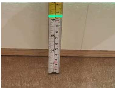
Fallforhold ca. 105 mm overkant gulv ved terskel
