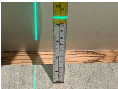
Fallforhold ca. 110 mm overkant gulv ved terskel
