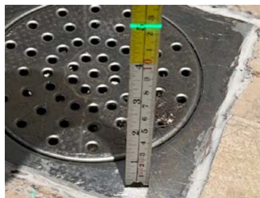
Fallforhold ca. 125 mm topp slukrist i dusjsone
