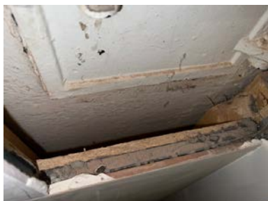
Sotluke og baderomsvegg i kjeller
