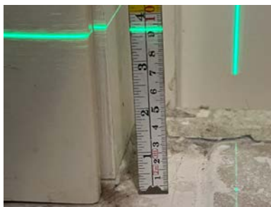
Fallforhold ca. 921 mm overkant gulv ved terskel
