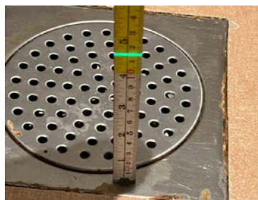
Fallforhold ca. 115 mm topp slukrist i dusjsone
