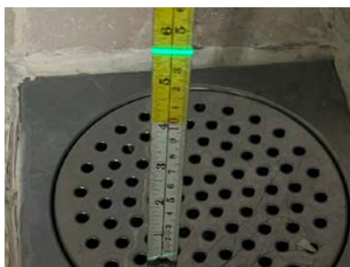
Fallforhold ca. 140 mm topp slukrist i dusjsone
