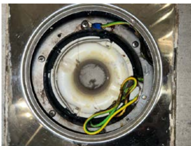
Plastsluk med klemring
