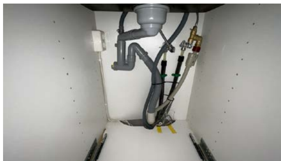
Besiktigelse av røropplegg.
