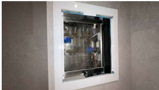
Besiktigelse av røropplegg.
