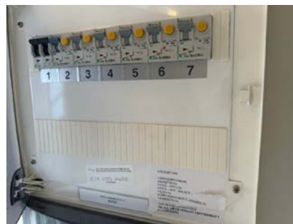
Sikringsskap med automatsikringer.
