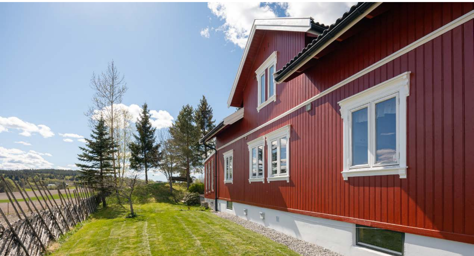
Hagen er avdelt fra øvrige området med naturlig vegetasjon og et gjerde. Gjerdet er i dårlig forfatning.
