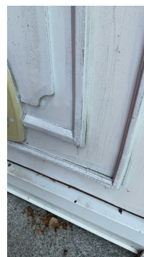
Karmene i dører er værslitte utvendig og det er sprekker i trevirket.
