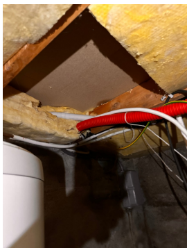
Manglende isolasjon i bjelkelag
