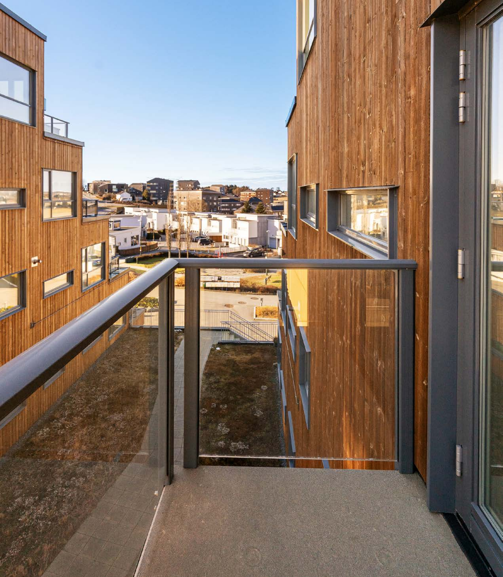
Balkong fra soverommet.
