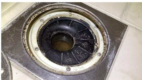
Kontroll av sluk.
