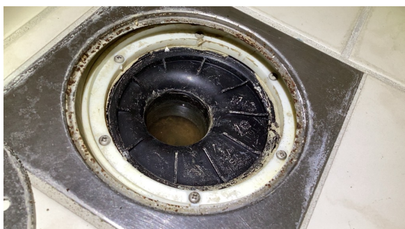
Kontroll av sluk.
