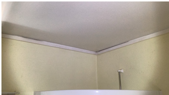
Sprekt fuge mellom taklist og himling.
